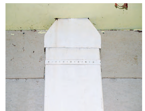
Asbestos flue pipe
