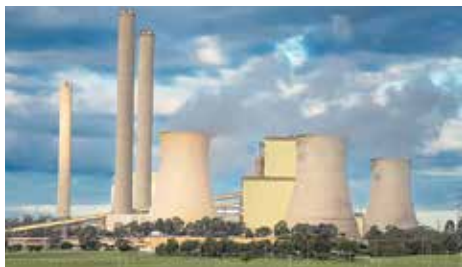
Loy Yang Power Station
